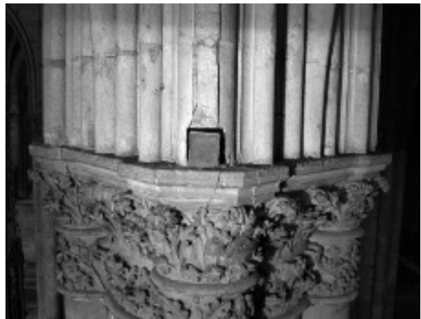
Fig. 1 : Bouline en place avant prélèvement.
